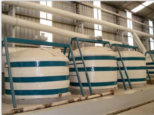
CAPTACION DE VAPORES CONDUCIDOS A TORRE DE LAVADO
